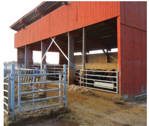
Betonēta barošanas vieta ļauj šo zonu saglabāt tīru.
