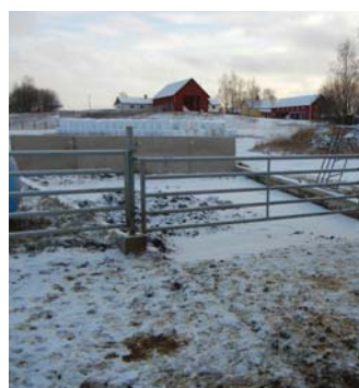
Cietie mēsli tiek glabāti uz betona plāksnes.
