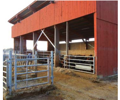
Betonēta barošanas vieta ļauj šo zonu saglabāt tīru.
