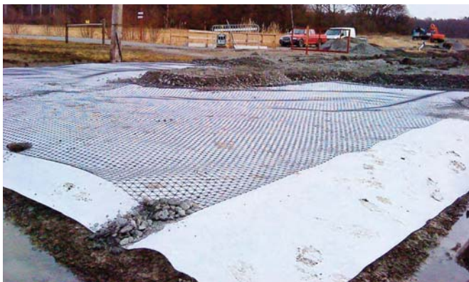
Ģeotekstils un ģeorežģis novērš apakšā esošās zemes sajaukšanos smilšu un grants virskārtu, kad lopi pa to midās. Ģeotekstils tiek izklāts uz līdzenas virsmas. Lai nostiprinātu zemi, ģeotekstilam pāri tiek uzklāts ģeorežģis.
