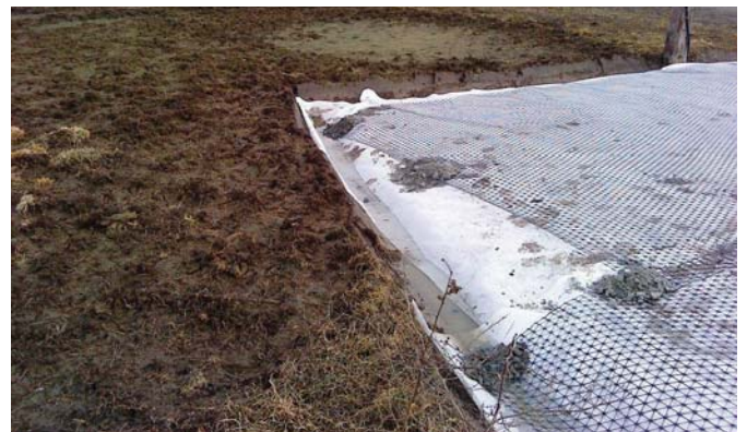
Lai nostiprinātu ģeotekstila un ģeorežģa malas, vietās, kur tās tiek nolocītas, ir izrakts grāvis.
