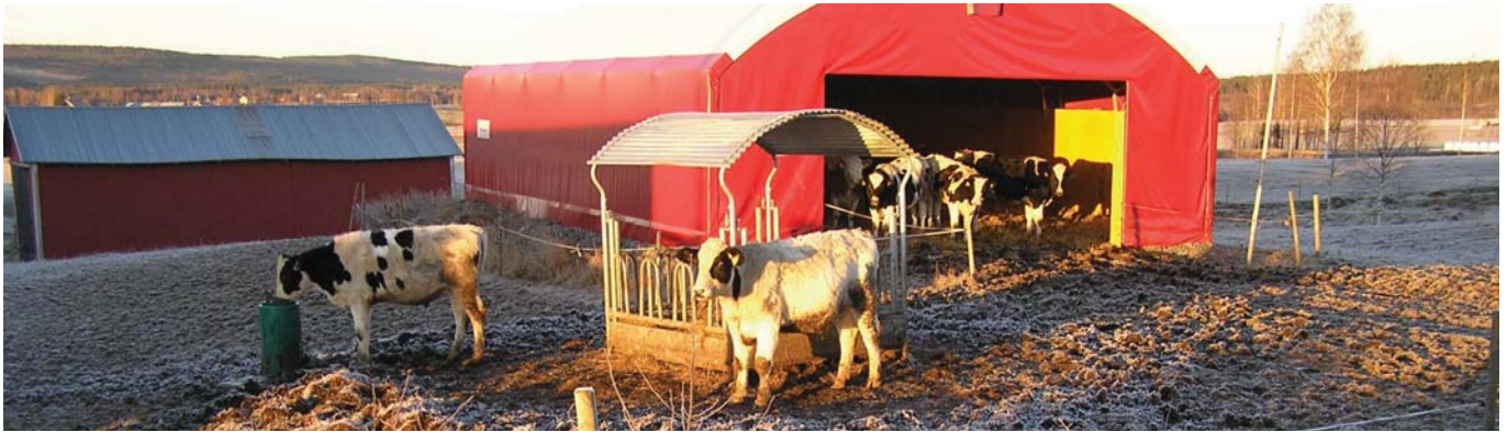
Vienkāšā būve ar barošanas un dzirdīšanas vietu. Zeme ir aizsargāta ar ģeotekstilu un granti.
