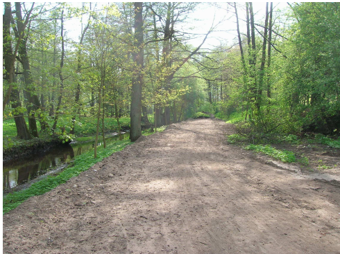
Ierīkotais velosceļņa uzbērumš ir 4-6 metrus plats.
